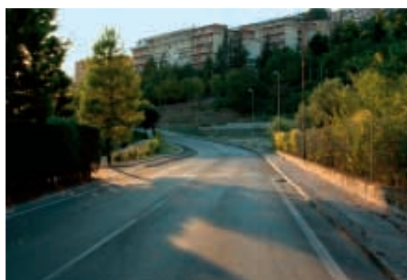
Asfaltatura strade Osimo sud
