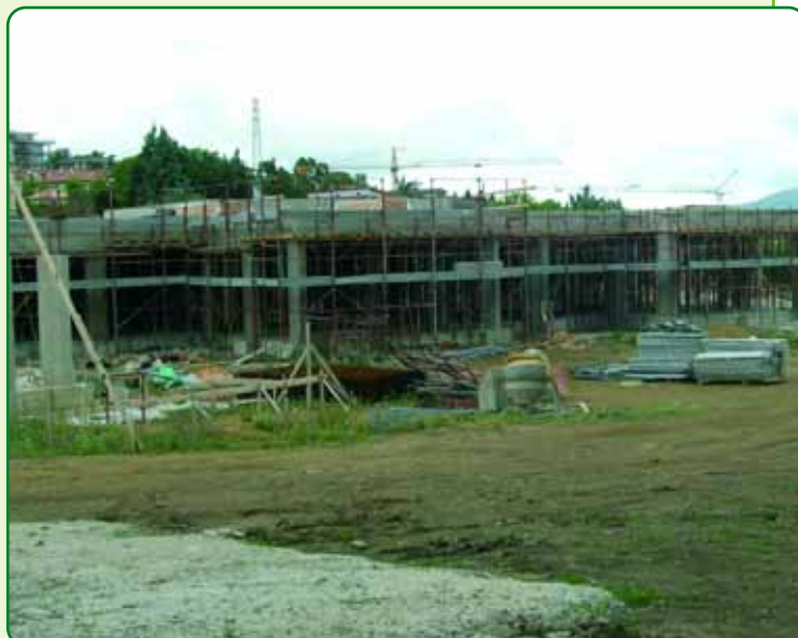
Il cantiere della nuova scuola della Sacra Famiglia
